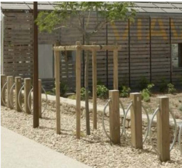
Afb. 3.8 - fietsparkeren op waterdoorlatend materiaal
