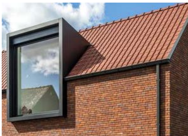
Afb. 2.31 - Referentie sobere dakrand en dakkapel
