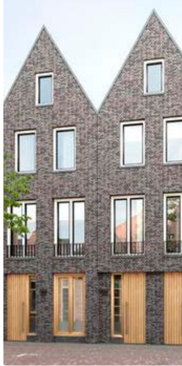
Afb. 3.33 - materialisatie baksteen in combinatie met hout
