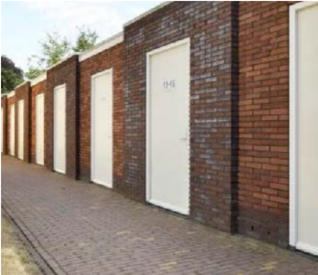
Afb. 2.80 - bergingen aan de achterzijde
