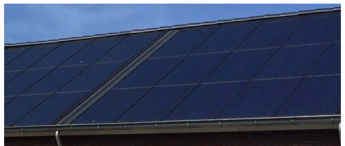
Afb. 2.94 - zonnepanelen geïntegreerd
