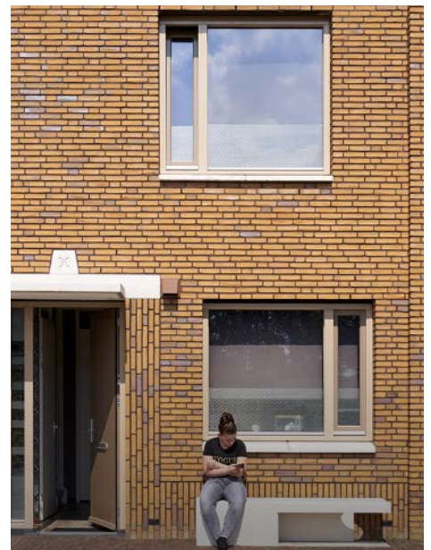
Afb 3.25 - meeontworpen zitelement in de gevel
