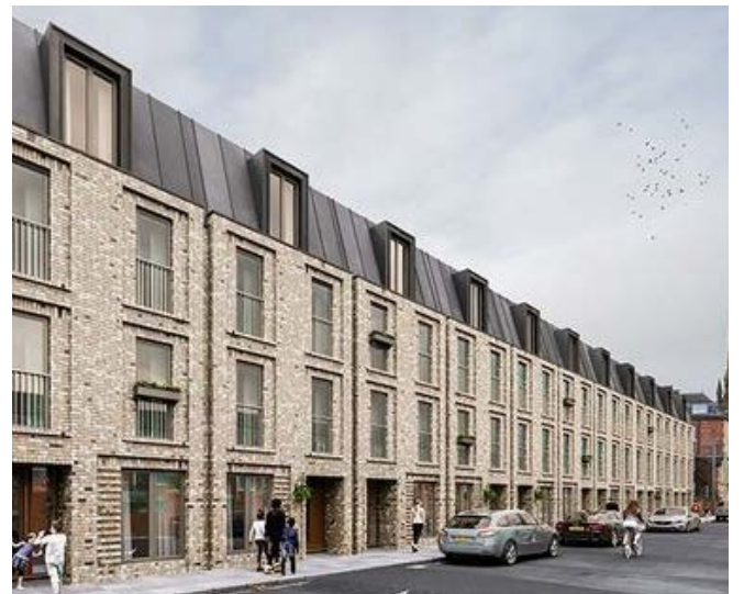
Afb. 3.46 - bovenste etage duidelijk afwijkend materiaal
