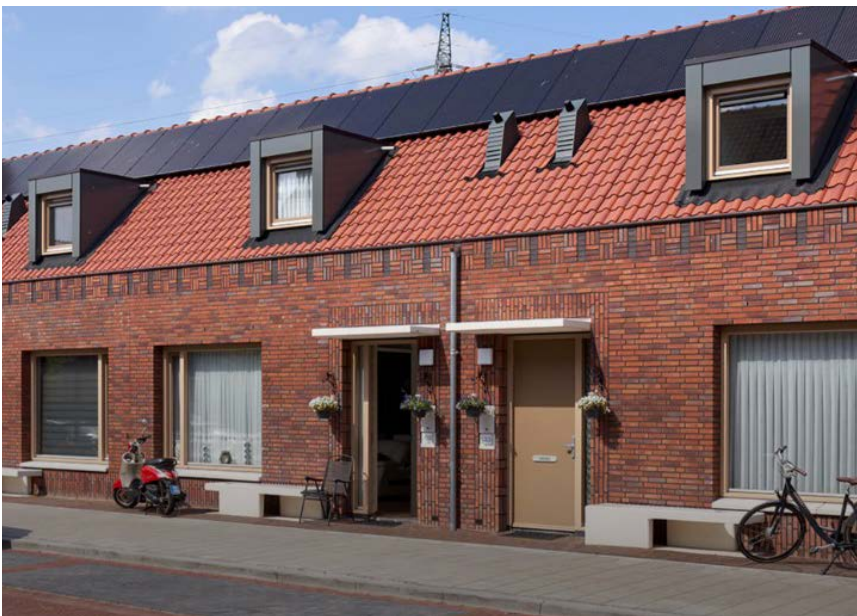
Afb. 3.24 - zadeldak langskap, sociale woningbouw
